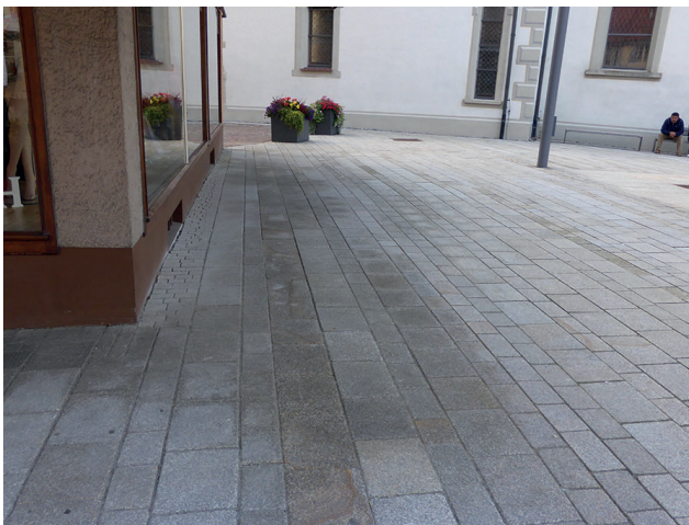
(1) Überdachte Fläche mit unterschiedlichen Steinformaten in ungebundener Bauweise (Bild: © Erich Lanicca)
