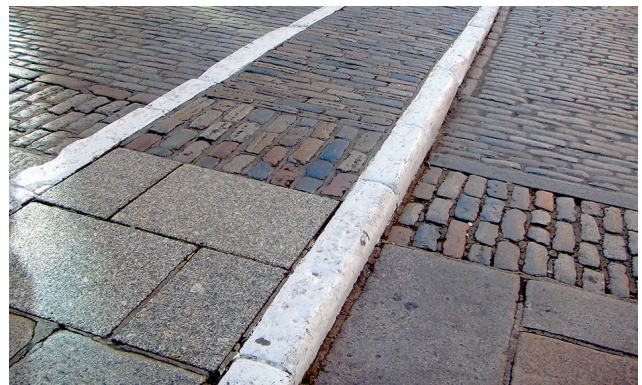
(3) Pflastersteine als Orientierungshilfe (Bild: © Maria Auböck)
