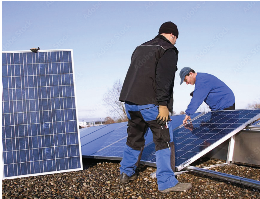
3 | Ist nach Errichtung eines Neubaudaches, nachträglich die Installation einer PV-Anlage geplant, sollte auf die Nichtbrennbarkeit der verwendeten Baustoffe geachtet werden. Gerade das Material der Dachabdichtung ist nach Fertigstellung des Daches oftmals endgültig.
