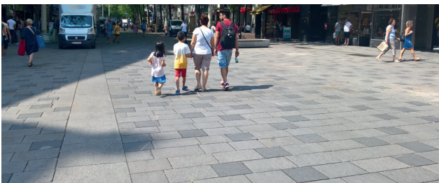
(14) Platten im Reihenverband, enge ungebundene Fuge und ebene sandgestrahlte Oberflächen eines geschnittenen Granitmaterials ermöglichen einen lärmarmen Pflasterbelag (Wien). (Bild: © Walter Zimmerer)
