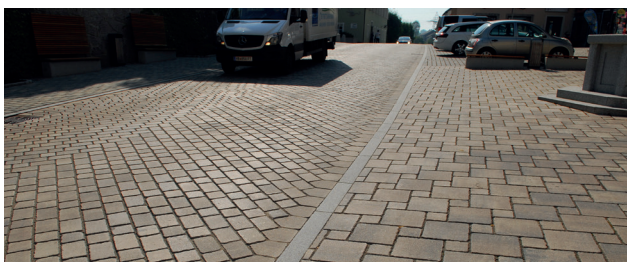
(16) Betonsteine unterschiedlicher Formate, in der Fahrbahn diagonal verlegt. Diagonale und Formatwechsel wirken schalltechnisch günstig. Die relativ breite Fuge ist ein Tribut an das gewünschte optische Erscheinungsbild, regt aber die Schallentstehung in einem sensiblen Frequenzbereich an. (Bild: © Weissenböck – www.steine.at)
