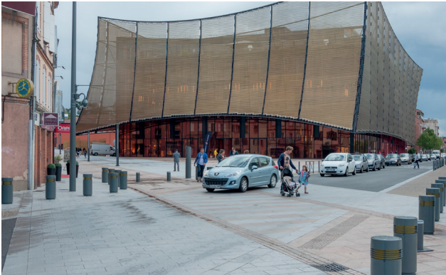
(13) Diagonal zur Fahrtrichtung verlegte Pflasterplatten mit schmalen Fugen, eben verlegt. Die Gliederungen sind durch Farbakzente gesetzt. Als punktuelle Querungsstelle ist hier eine Pflasterfläche lärmarm umgesetzt (Albi). (Bild: © Walter Zimmerer)
