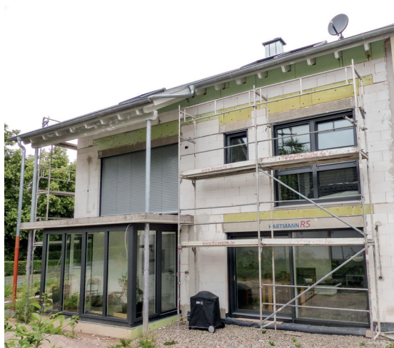
Abb. 6.1.1-1: Einfamilienhaus mit Luft-Wasser-Wärmepumpe, Quelle: BWP
