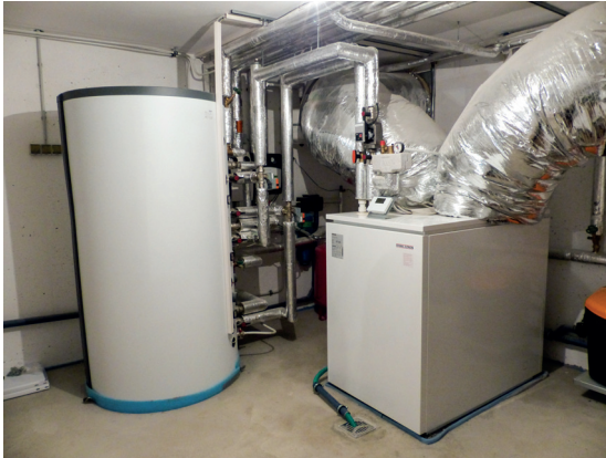
Abb. 6.1.1-2: Luft-Wasser-Wärmepumpe, Quelle: BWP
